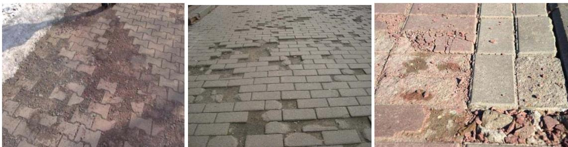
Рисунок 1. Фрагменты разрушения тротуаров, устроенных из бетонных брусчаток.
